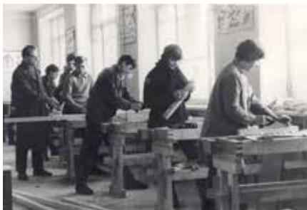
В мастерских строительного техникума, 1968 г.
